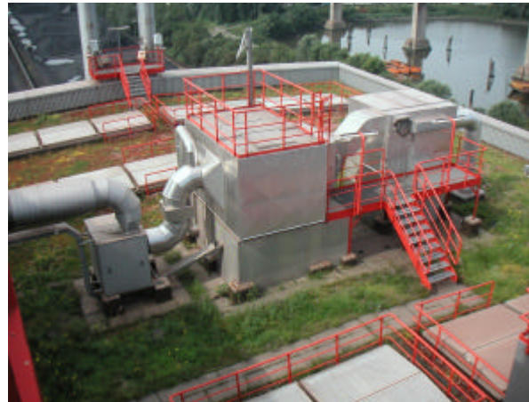
Filteranlage zur Geruchsminderung
